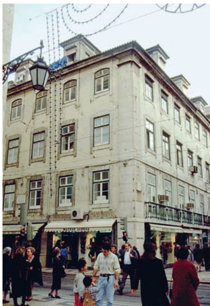
Immeuble pombalien, technique constructive développée après le tremblement de terre de 1755, état non altéré par des déviations postérieures, Lisbonne, Portugal.
