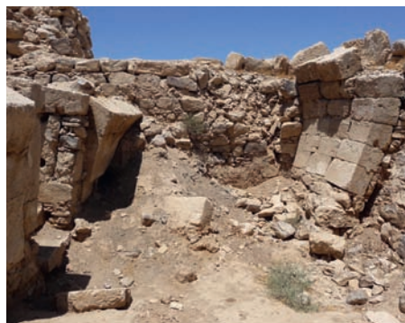
Basculement de voûte avec rotation, v-vi e siècle ap. J.-C., Umm-ar-Rasas, Jordanie.
