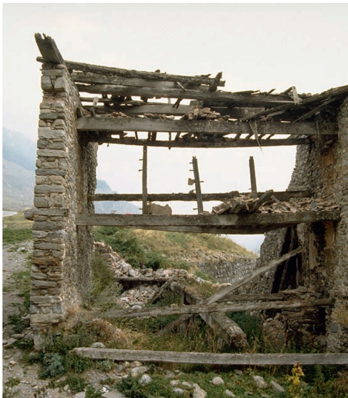
Tirants bois intégrés à la construction, Grangie, Italie.
